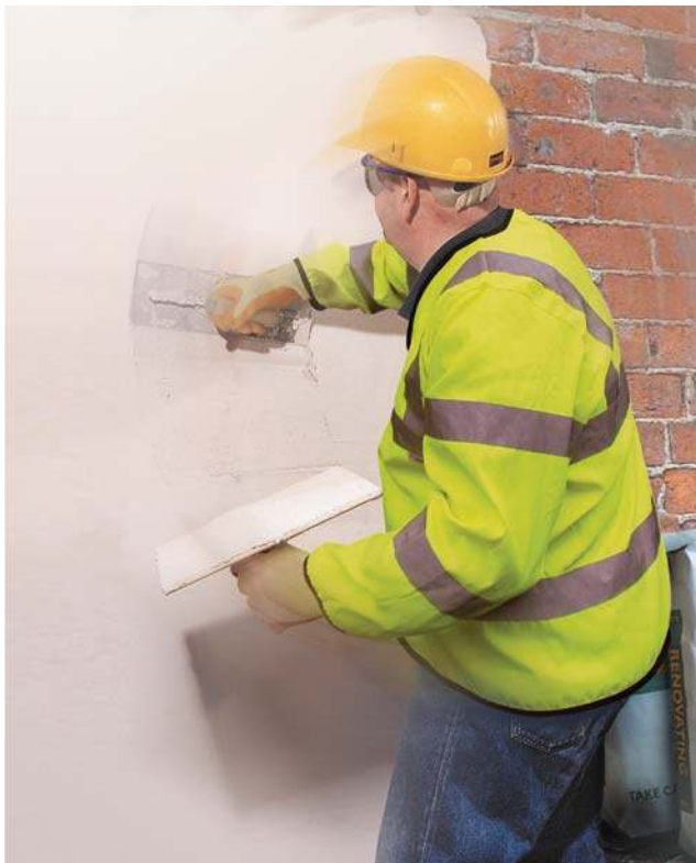
Riqualificazione edilizia con i prodotti e i sistemi a base gesso
