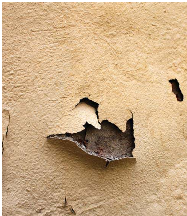
Nella foto l'effetto dell'umidità sui muri
