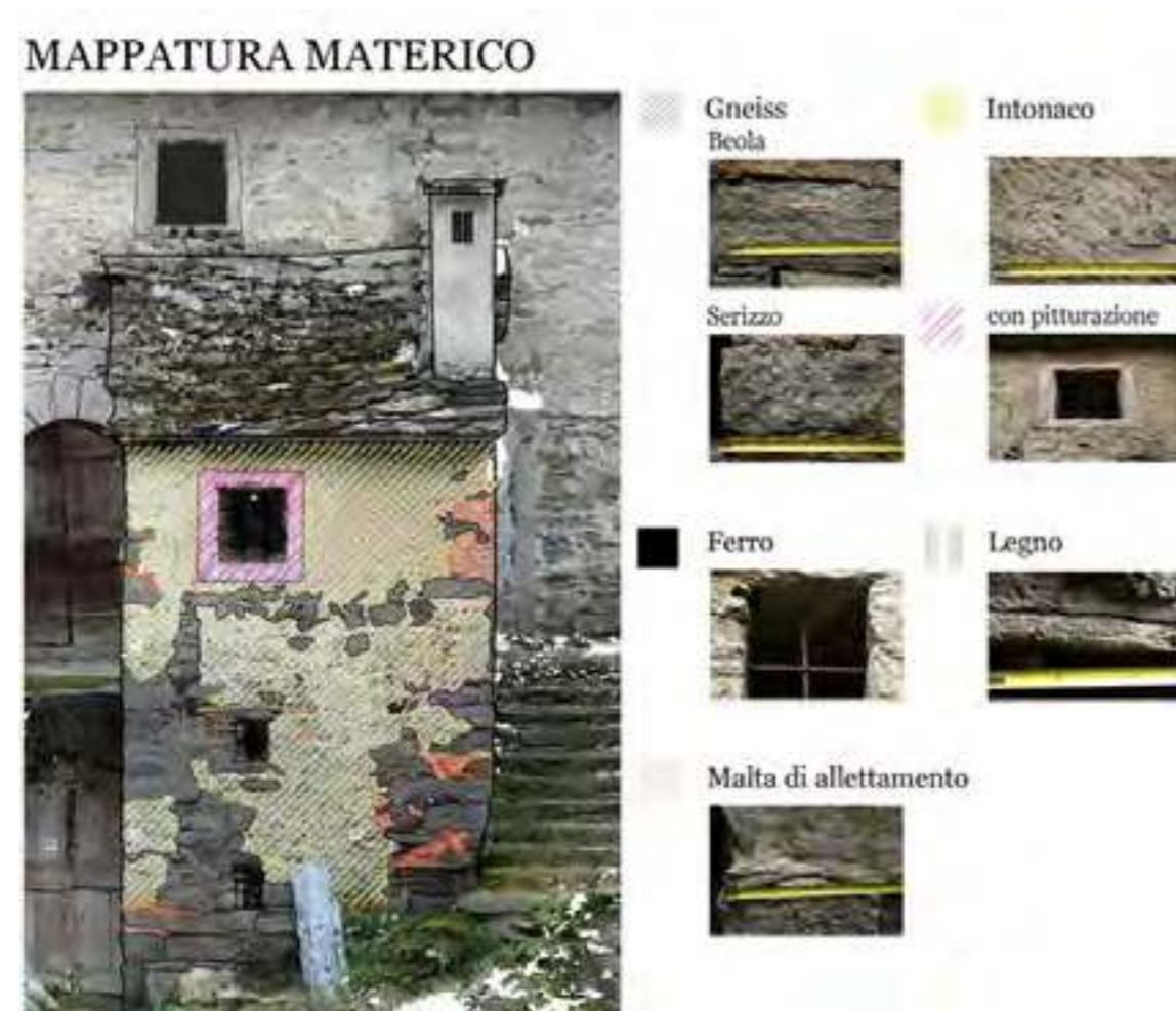
Fig. 8. La mappa del degrado e dei costituenti
