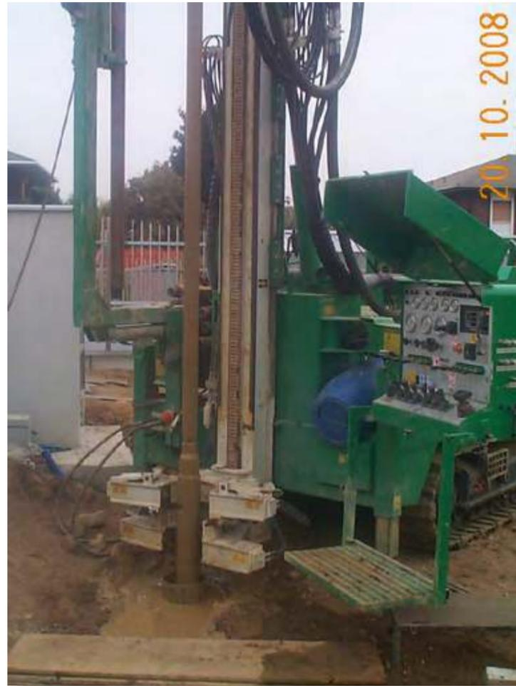
02: Cantiere di terebrazione di un pozzo mediante cingolata che utilizza la tecnica di perforazione "a rotopercolazione"
