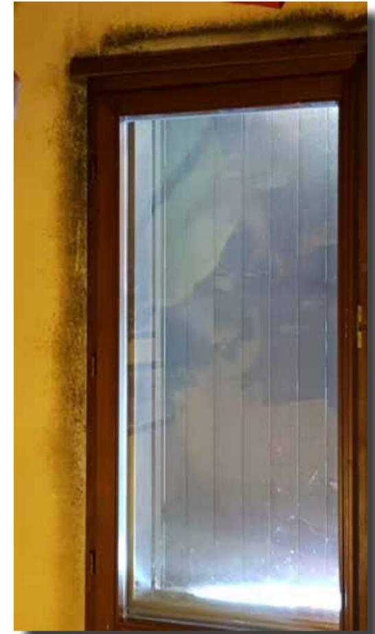
Figura 4: Muffe e condense in corrispondenza dei serramenti
