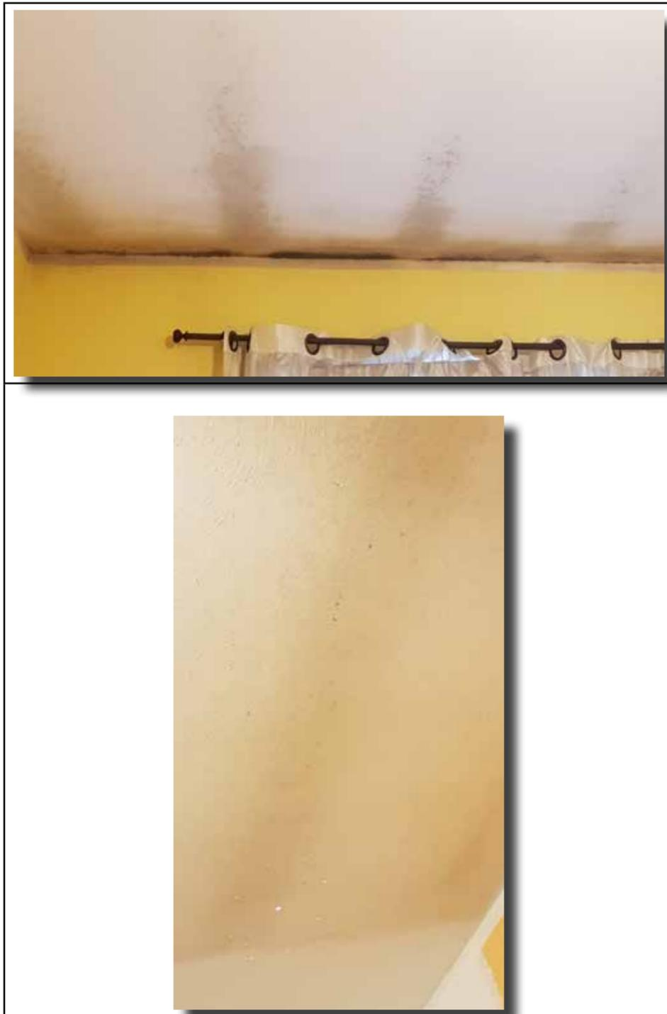
Figura 3: Muffe e condense sul soffitto al primo piano
