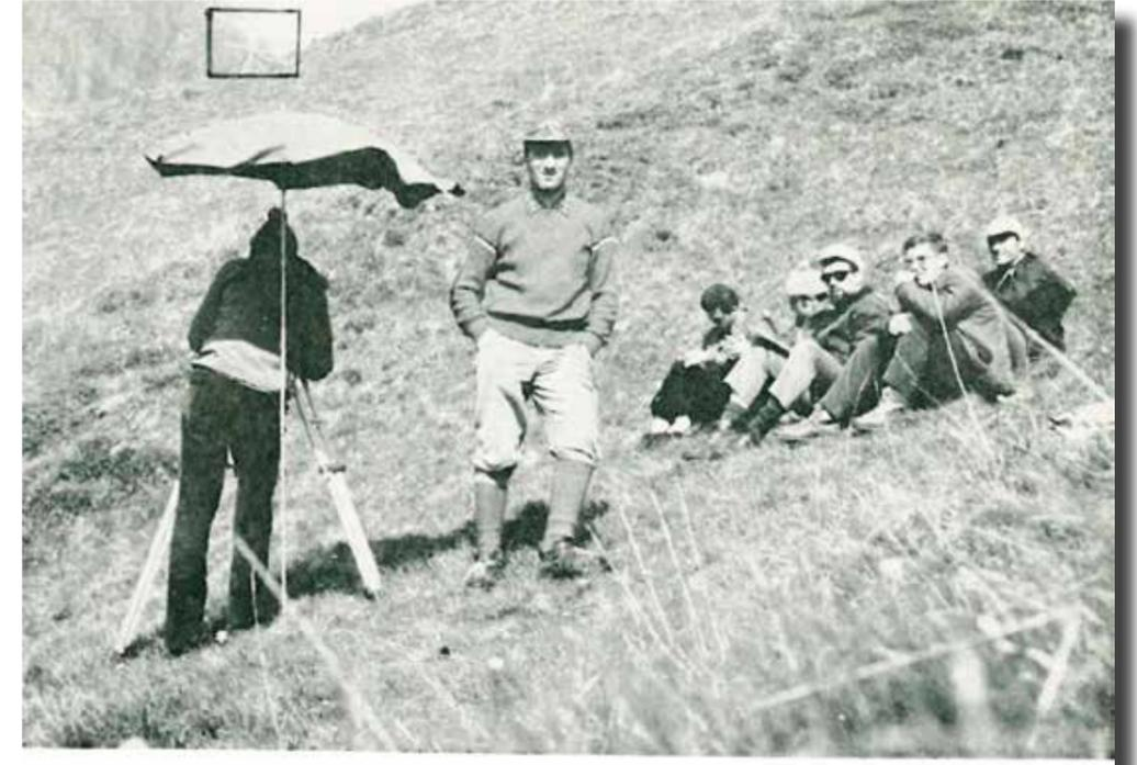
Fig. 3. La misura della base: nel riquadro in alto a destra, la lontana mira orizzontale. L'autore è qui di fronte, a lato dell'ombrellone.
