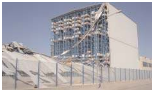
Gravi danni ditta "Ceramiche Sant'Agostino"
