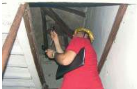
Geometra Bini; ispezione sottotetto di un edificio inagibile
