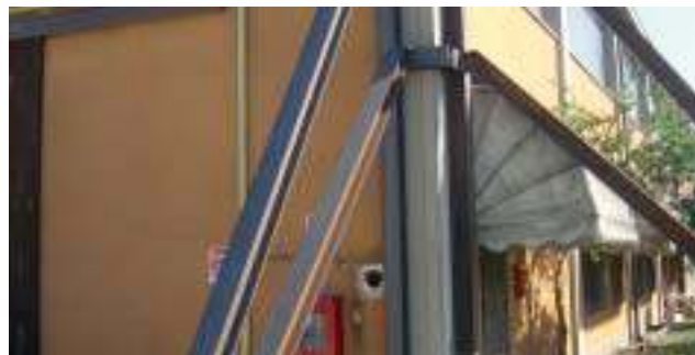
Puntellamento di angolo di edificio industriale
