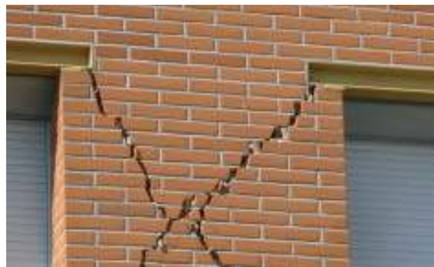
Gravi lesioni edificio ASL di Cento
